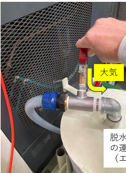
吸込みホース口90度ボールバルブ 脱水時のレバー位置 (開放) 約10分間ポンプ運転のまま待機
