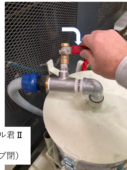
脱水完了後90度ボールバルブを濾過 作業時のレバー位置 (閉鎖) へ戻す その後蓋を開けフィルター交換作業へ
