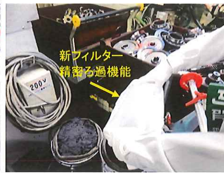
新フィルターをペール缶に設置
