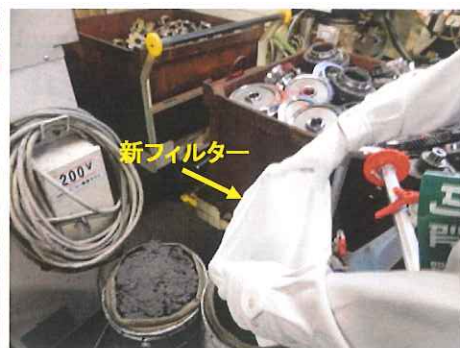
新フィルターをペール缶に設置
